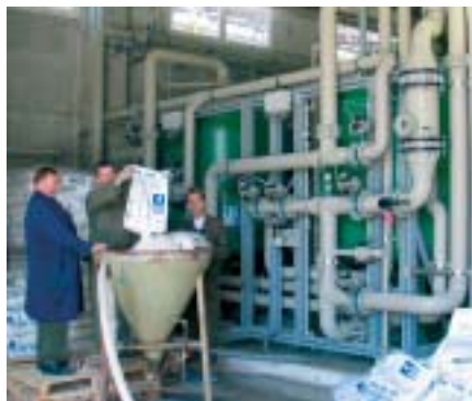
Prvo polnjenje demi kolon z ionsko maso
