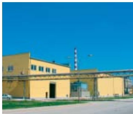
Pogled na celoten objekt priprave vode
