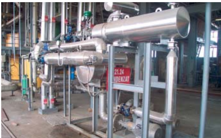
Toplotna postaja za koriščenje odpadne toplote
