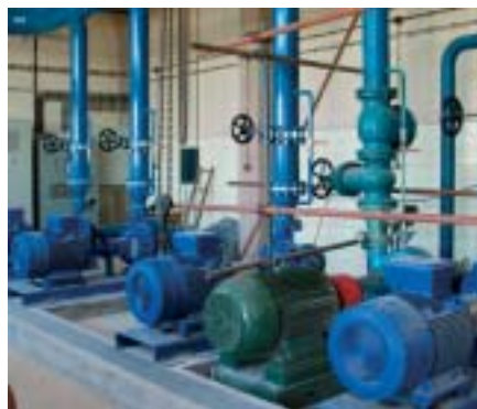
Novo črpališče Nivo
